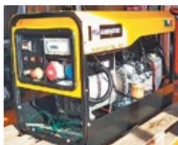
**Notstromaggregat WFM B14000-TDE-AVR**, Jg. 2019, 100 Std., 190 kg, 2 Zyl. Lombardini Dieselmotor, 10 kW Konstantleistung, Verbr. b. Vollast 4.4/l/h, Tank 20l, Masse 100x55x67 cm, Anschlüsse 1x CEE 16/5, 1x T23, FI-Schutzschalter
