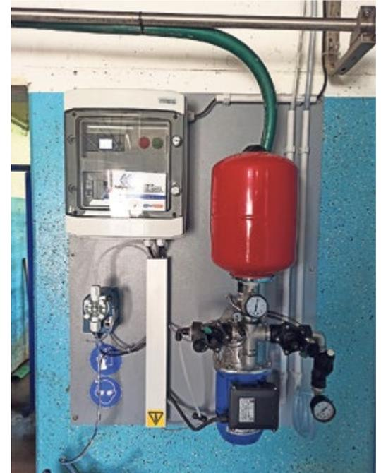
Druckerhöhungsanlage und Steuerung
