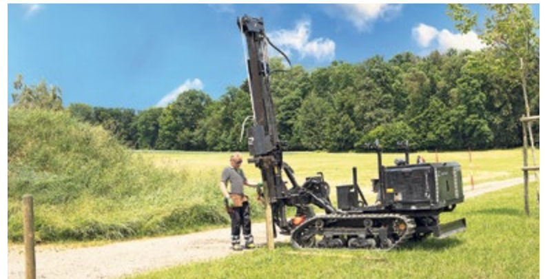
Walter «Wädi» Hübscher beim Rammservice
