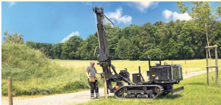
Walter «Wädi» Hübscher beim Rammservice
